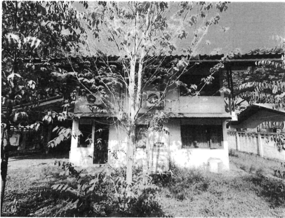
ภาพถ่ายบริเวณพื้นที่ก่อสร้างบ้านพักหัวหน้าสำนักงานจังหวัดอุดรดิตถ์ ตำบลท่าเสา อำเภอเมืองอุดรดิตถ์ จังหวัดอุดรดิตถ์ (หลังเดิม)
